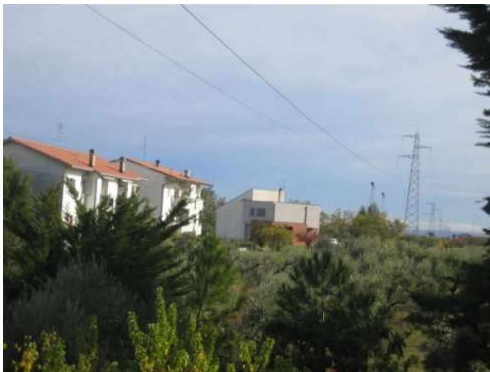
Figura 16. Vista della linea elettrica a 150 kV dall'edificio di San Giacomo degli Schiavoni in cui sono state effettuate le misure prolungate.
